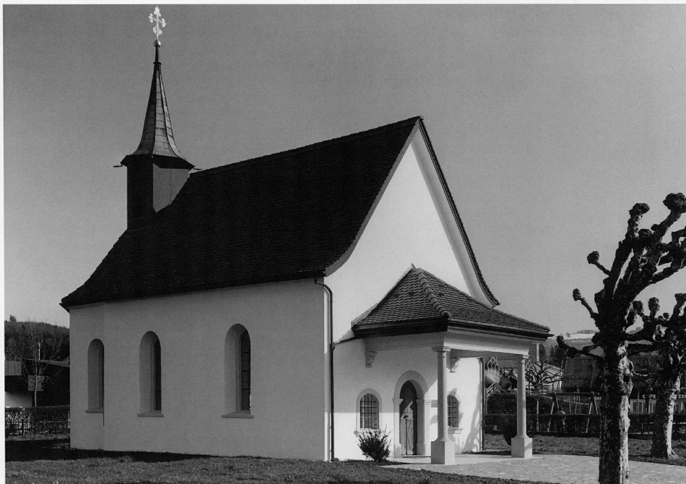
Abb. 2 Baar, Schutzengelkapelle von Nordwesten nach der Restaurierung, 1993.
