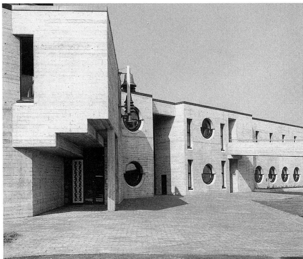
Abb. 29 Steinhausen, Kirchen- und Gemeindezentrum. Blick nach Westen 1981.
