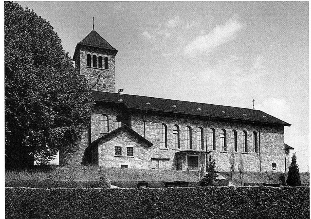
Abb. 1 Rotkreuz, Katholische Kirche. Ansicht von Süden, 1990.
