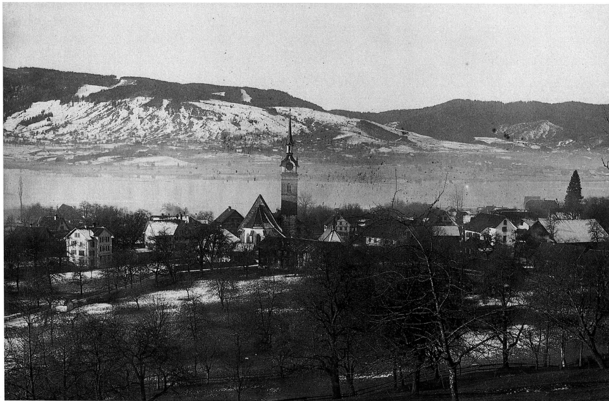
Abb. 47 Oberägeri vor 1905: Sicht in westlicher Richtung; in der Bildmitte die alte Pfarrkirche St. Peter und Paul.
